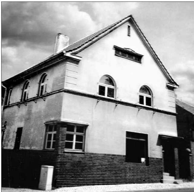
Haus in der Meininger Straße 102.
